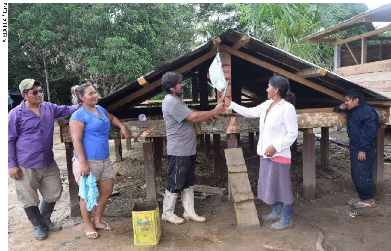
▲ Culminación de la construcción del secador de castaña en la Comunidad Nativa de Masenawa.
